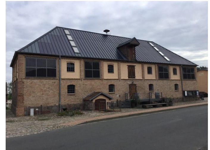
Photovoltaikanlage Alter Speicher Nechlin
