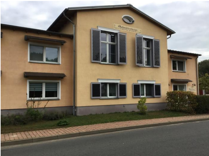
Solare Fensterläden und Sonnenschutz am Schnitterhaus Nechlin
